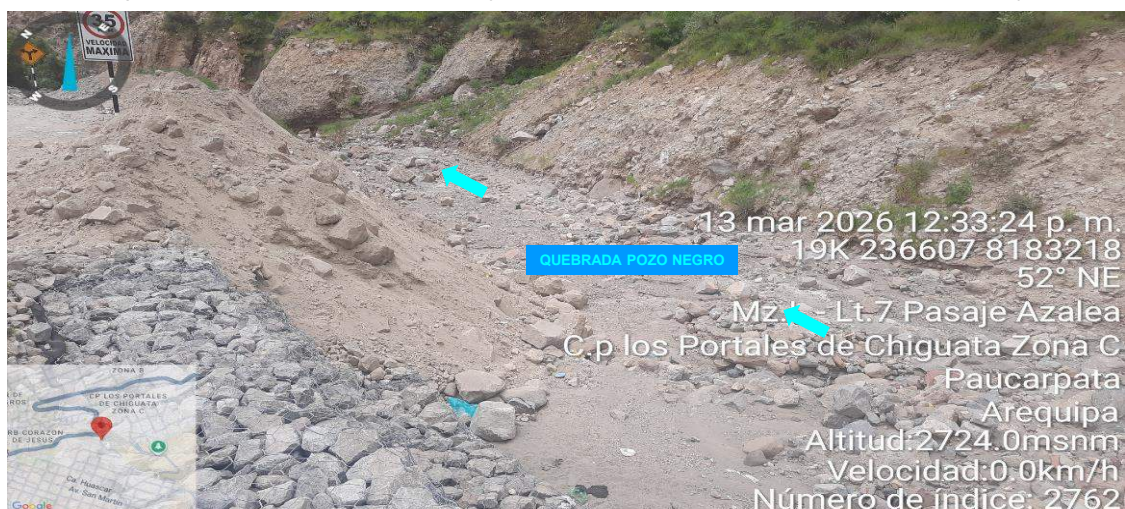
Imagen N° 2. Zona colmatada en el tramo, en donde se observa sedimentación en el cauce de la quebrada Pozo Negro.
