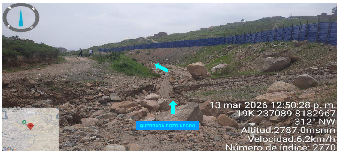
Imagen N° 3. Zona colmatada en el tramo, en donde se observa sedimentación en el cauce de la quebrada Pozo Negro.
